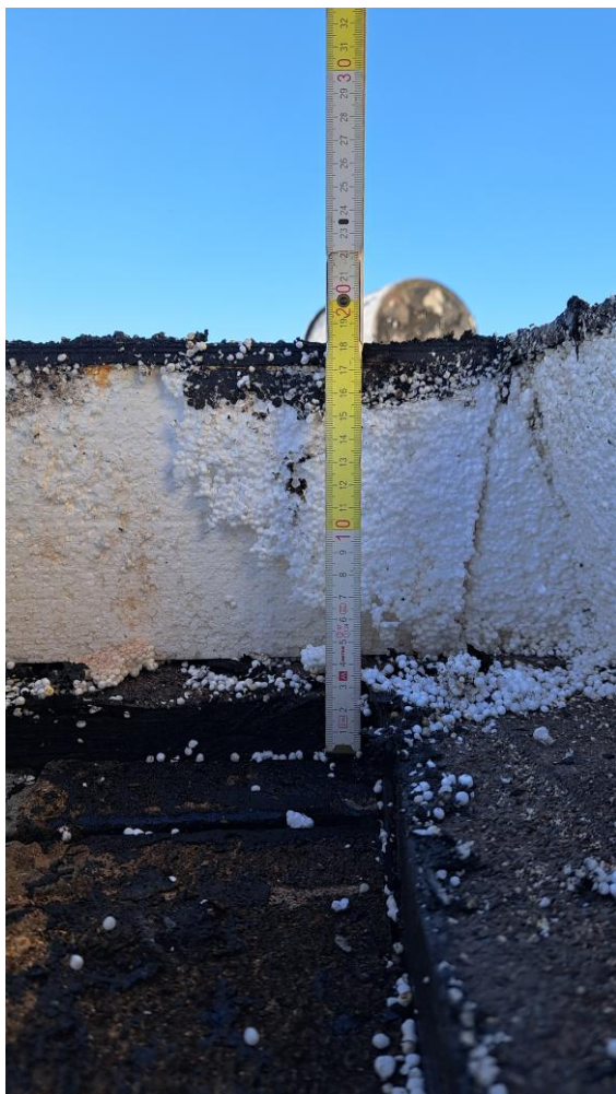
Tabulka 1 – skladba v místě sondy S1 (od exteriéru)
